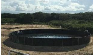
Puede ubicarse recubriendo un tanque de tierra o bien recubriendo un estanque sobre el nivel del suelo con una valla metálica electrosoldada. aísla el cultivo de todos aquellos agentes nocivos provenientes del suelo tanto físicos, químicos como biológicos (sales, metales pesados, ácidos, pesticidas y herbicidas, virus.
