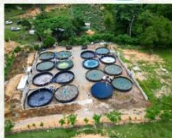
Los estanques de geomembrana son una solución moderna y eficiente en acuicultura. Estos estanques están revestidos con una membrana impermeable que aísla el cultivo de posibles contaminantes del suelo.
