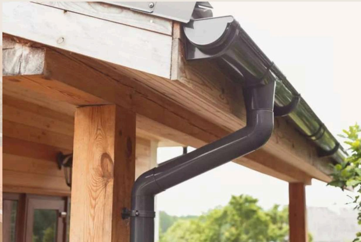
aguas de escorrentia de lluvia: se capta mediante canaletas que manda al liquido a un contenedor de captacion el cual contiene filtros de diferente grandolomentia el caul la limpia de impurezas haciendola apta para uso en el area de lavado o area blanca, asi como riego y uso del w.c, mas no la purifica “ no apta para el consumo humano”
