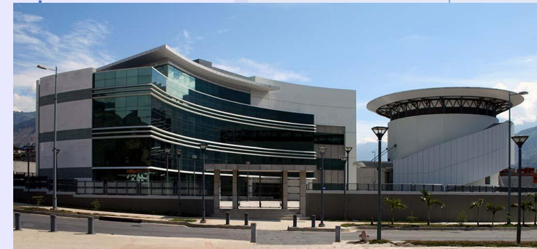
CENTRO OPERATIVO Y ADMINISTRATIVO DEL SISTEMA TROLEBÚS
