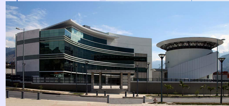
CENTRO OPERATIVO Y ADMINISTRATIVO DEL SISTEMA TROLEBÚS
