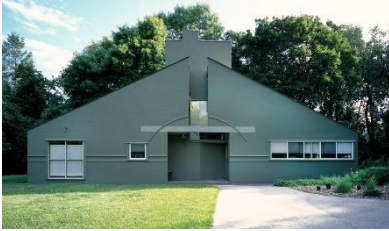
Casa Vanna Venturi (1964)
