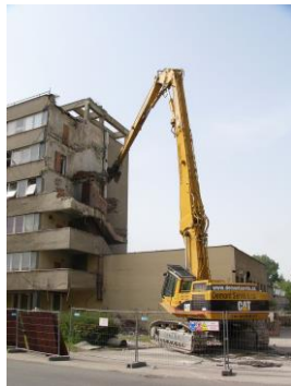
Demolicion Mecanica
