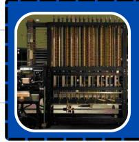
Babbage diseña la "Máquina Analítica", una computadora programable con tarjetas perforadas.
