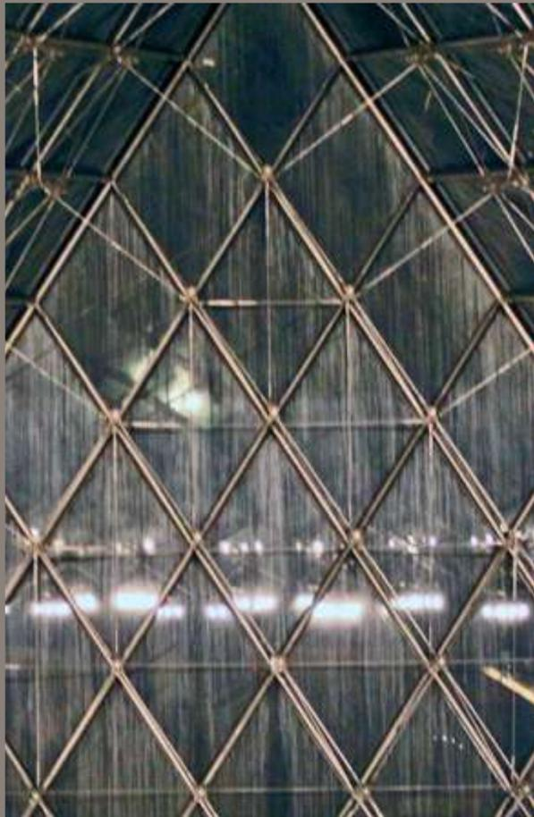
estructura de acero de 95 toneladas y por un bastidor de aluminio de 105 toneladas.
