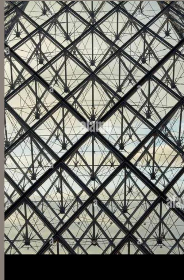
se compone de una malla de 2100 nodos, 6000 barras, 603 rombos y 70 triángulos de vidrio con un espesor de 21 mm.
