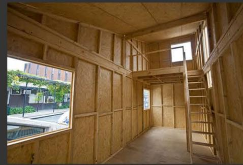
Tomando la madera como material constructivo esencial, dadas sus cualidades frente a los movimientos sísmicos, se diseñó un sistema constructivo de paneles y pilares que permite ampliar la vivienda, pudiendo remover paneles y reubicarlos sin la necesidad de desarmar gran parte de la estructura.
