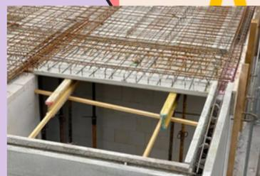
Este tipo de cimentaciones, son muy fuertes y de alta resistencia. Este sistema está compuesto por un conjunto de vigas longitudinales y transversales posicionadas como nervios, trabajando en conjunto para dar máximo soporte. El tipo de losa nervada es utilizada en estructuras desequilibradas, para brindar la fuerza necesaria.
