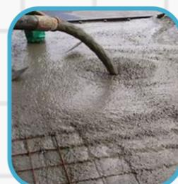
El cemento es un material pulverulento que por sí mismo no es aglomerante, y que, mezclado con agua, al hidratarse se convierte en una pasta moldeable con propiedades adherentes, que en pocas horas fragua y se endurece tornándose en un material de consistencia pétreo
