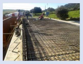
Esta es de concreto armado, es uno de los sistemas más comunes y antiguos. A pesar de tener una buena resistencia es una de las losas más delgadas. Es recomendable que el largo del lugar a cubrir no sea mayor a los 5 metros. Este tipo de materia tiene su apoyo y descansa su carga sobre vigas o muros, los cuales se lo transmiten a la cimentación y a su
