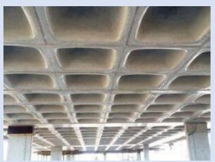
Este tipo de cimentaciones, son muy fuertes y de alta resistencia. Este sistema está compuesto por un conjunto de vigas de acero longitudinales y transversales posicionadas cómo nervios, trabajando en conjunto para dar máximo soporte. El tipo de losa nervada es utilizada en estructuras desequilibradas, para brindar la fuerza necesaria.
