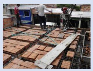
La placa fácil o Losa aligerada es un sistema que a pesar de ser muy ligero cuenta con resistencia, está compuesto de piezas de arcilla llamadas bloquelones, mayormente utilizada en techos o algún tipo de adición a su casa, este tipo de losa está constituída por 4 materiales; el perfil metálico, bloquelon, la malla electrosoldada y concreto. Es uno de los montajes más sencillos y rápidos, no requiere herramientas ni
