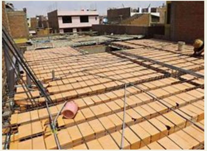
ES SIMILAR AL DE UNA LOSA NERVADA, PERO EN ESTE CASO LOS MATERIALES QUEDAN AHOGADOS O EMBEBIDOS EN LA LOSA, Y POR EL ACABADO FINAL NO SE VEN. SE UTILIZA CIMBRA COMPLETA DEBAJO DE LA LOSA
