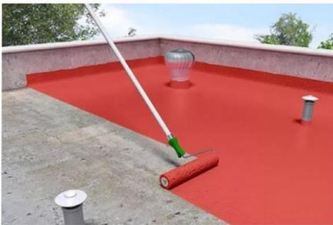
Los impermeabilizantes son sustancias que detienen el agua, impidiendo su paso, y se emplean en el revestimiento de paredes, techos y objetos que deben mantenerse secos. Funcionan eliminando o reduciendo la porosidad del material, llenando filtraciones y aislando la humedad del medio.
