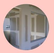
Está compuesta d un núcleo de yeso resistente al fuego recubierto de una superficie de papel 100% reciclado de acabado manila en la cara aparente y acabado natural en la parte posterior
