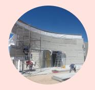
El tablero de cemento Durock® es una placa rectangular de cemento reforzado con doble malla de fibra de vidrio resistente a la humedad y a la intemperie, no inflamable y libre de asbesto, en medidas de 1.22x2.44 de 12.7 mm de espesor para uso en muros y plafones de zonas en contacto con el agua y fachadas.
