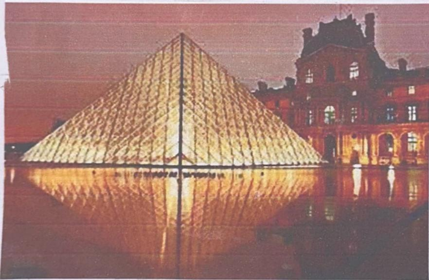
La estructura metálica que sostiene el revestimiento de vidrio está hecha de acero y aluminio y pesa 200 toneladas. Tiene una altura de 21.64 mts sobre una base de 35,42 mts.
