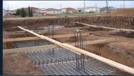
**Se emplean cuando la capacidad resistente del suelo es media-alta y por lo tanto la carga del pilar se puede transmitir directamente al terreno. En algunas ocasiones este tipo de zapatas se unen mediante vigas de hormigón armado, conocidas como riostras, en busca de que no se produzcan asentamientos diferenciales.**
