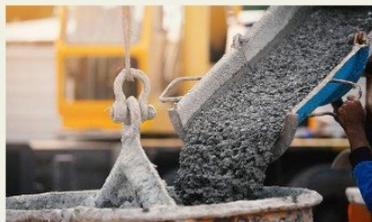
EL CONCRETO Y HORMIGÓN ES UN MATERIAL COMPUESTO EMPLEADO EN CONSTRUCCIÓN, FORMADO ESENCIALMENTE POR UN AGLOMERANTE AL QUE SE AÑADE ÁRIDOS (AGREGADO), AGUA Y ADITIVOS ESPECÍFICOS.
