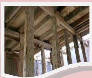
Es una estructura auxiliar que sirve para sostener provisionalmente el peso de un arco o bóveda, así como de otras obras de cantería, durante la fase de construcción. Suele ser una cercha de madera.
