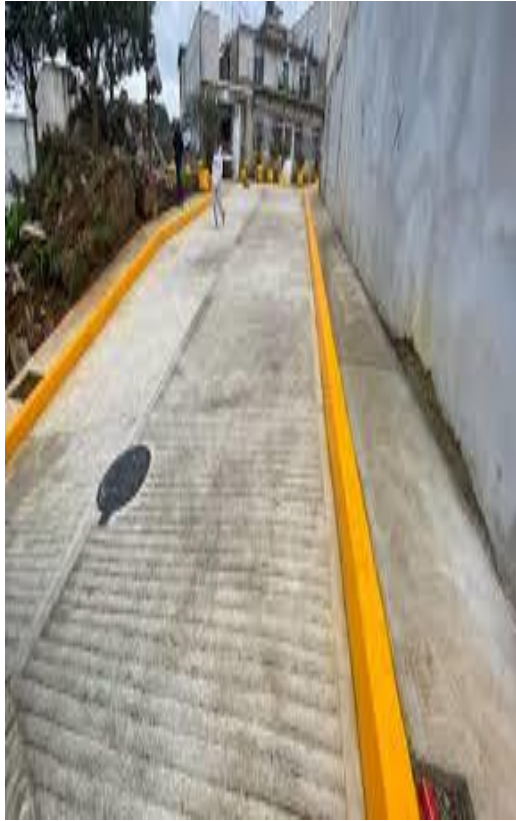
Guarniciones de 0.20 m de peralte de concreto hidráulico
