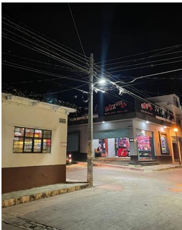
Poste de concreto pcr-11-500 (brinda soporte para la red de distribución eléctrica aérea)
