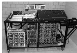
4. En 1932 Vannevar Bush construyo en el Instituto Tecnológico de Massachussets (MIT) una calculadora electromecánica conocida como el analizador diferencial, pero era de propósito específico y no tenía capacidad de programación
