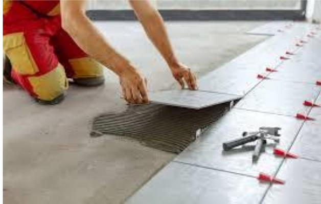
La alta resistencia del revestimiento **cerámico** y el bajo nivel de absorción de agua lo hacen ideal para su **uso** en ambientes húmedos, como cocinas, baños y áreas al aire libre. Debido a que no es poroso, es extremadamente resistente al agua y muy fácil y rápido de limpiar, evitando que el agua llegue a la capa debajo.
