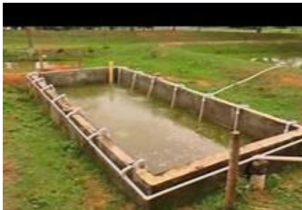
Pasos para la construcción
