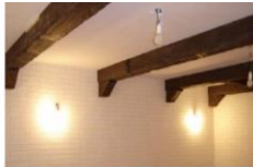
Vigas de madera apoyadas sobre ménsulas
