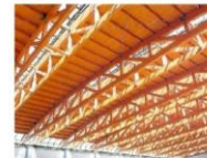
Vigas de celosía
