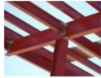
Vigas con perfiles metálicos
