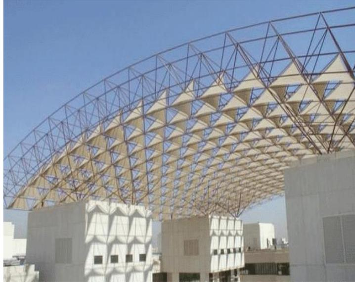
armaduras. Pero en todas coincide la unión de elementos rectos que forman puntos de unión llamado nudos en los que reside el esfuerzo de carga que la estructura realiza. La forma que la cercha o armadura adquiera tendrá mucho que ver en el diseño para el cual ha sido creada. Construir la estructura para un techo será muy diferente al diseño implementado para un puente.
