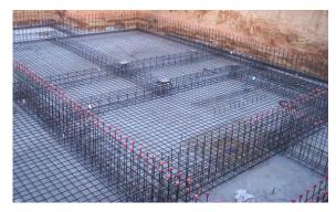
del terreno y el impulso de las aguas subterráneas. Las losas de cimentación pueden utilizarse en varios escenarios, como por ejemplo cuando la estratificación del terreno es desigual y se prevén asientos irregulares o cuando la estructura tiene una superficie menor en comparación con su volumen (edificios muy altos, silos, tolvas o depósitos).
