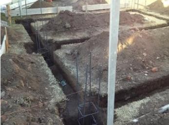
**Pilares, ubicación y distancia entre ellos.** En aquel se estipula que la separación entre columnas debe ser máximo la medida del doble de la altura de la pared de ladrillos. Es decir, si la altura de esta pared es de 2.40 metros, las columnas deberían estar separadas, como máximo, por 4.80 metros. Detalles de los estribos de cada modelo de pilar.
