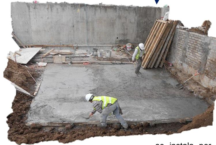
se instala por debajo de las cimentaciones con el objetivo de dividir el suelo del acero o cimiento, la plantilla protege a la zapata para que su resistencia no sea afectada por las reacciones que se producen en el suelo
