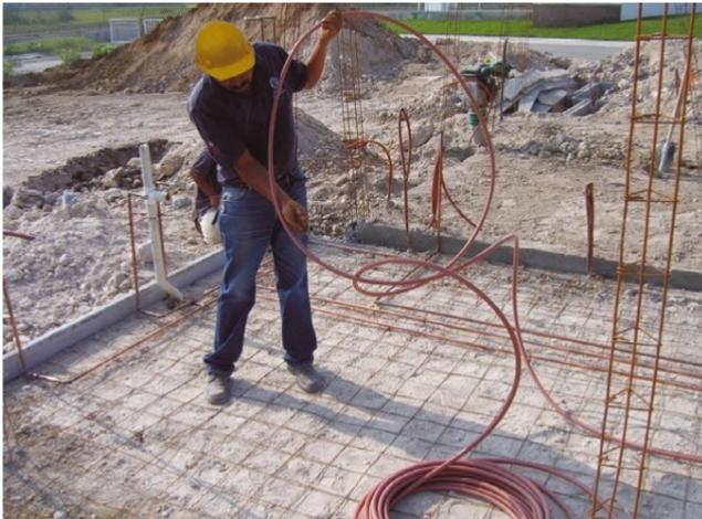
Verifica que se fije la tubería del sistema eléctrico a la malla electrosoldada para que no se mueva durante el vaciado del concreto.
