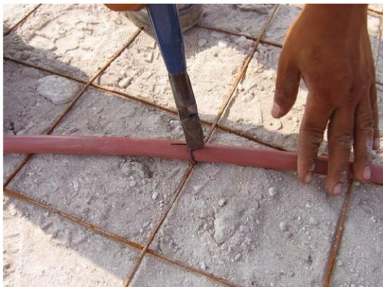
Verifica que se instale la tubería del sistema hidráulico y se coloquen aislantes en los puntos de cruce entre las tuberías, que servirán como amortiguadores, aislantes térmicos o eléctricos para evitar dañar la tubería durante el vaciado del concreto.
