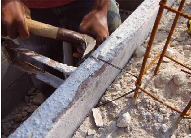
Puedes usar también un clavo sobre la madera para dar el espesor del firme de concreto especificada en el plano.
