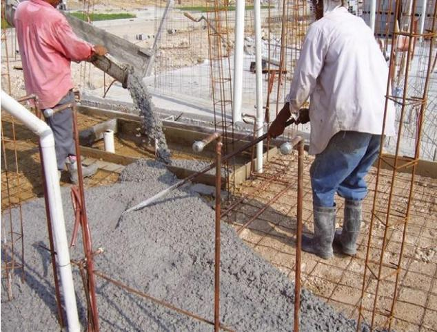
Evita que el concreto se contamine con tierra o cualquier otro material.
