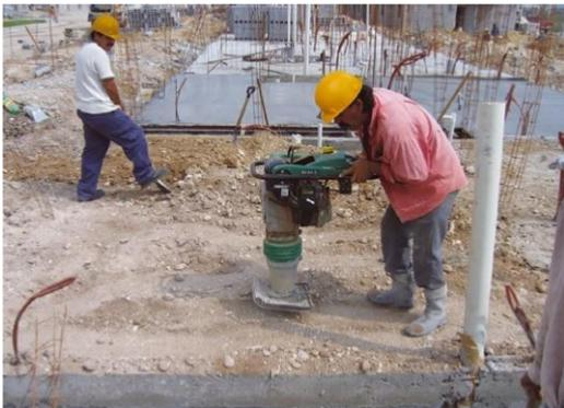
El proceso de compactación también lo puedes realizar manualmente, principalmente donde hay tubería hidráulica o sanitaria que tenga el riesgo de sufrir daños por la maquinade compactación.
