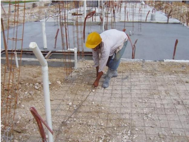
Si se usan traslapes, verifica que el traslape sea como mínimo 20 veces el diámetro de la varilla de la malla.
