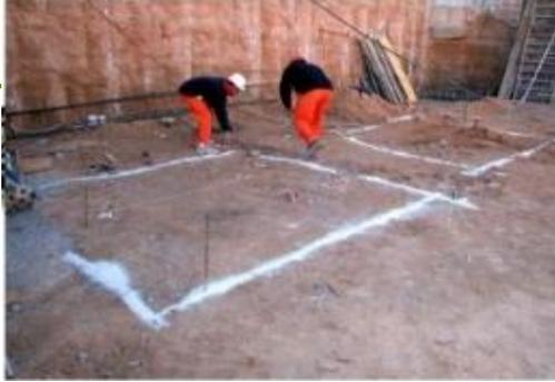
Traza de perpendiculares: se emplea con una escuadra haciendo coincidir los hilos con los bordes de la misma. Cuando esta lista, se amarran los hilos sobre los puentes y se vuelve a rectificar con la escuadra.
