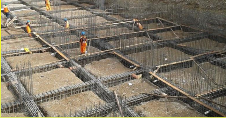
Losa de cimentación
