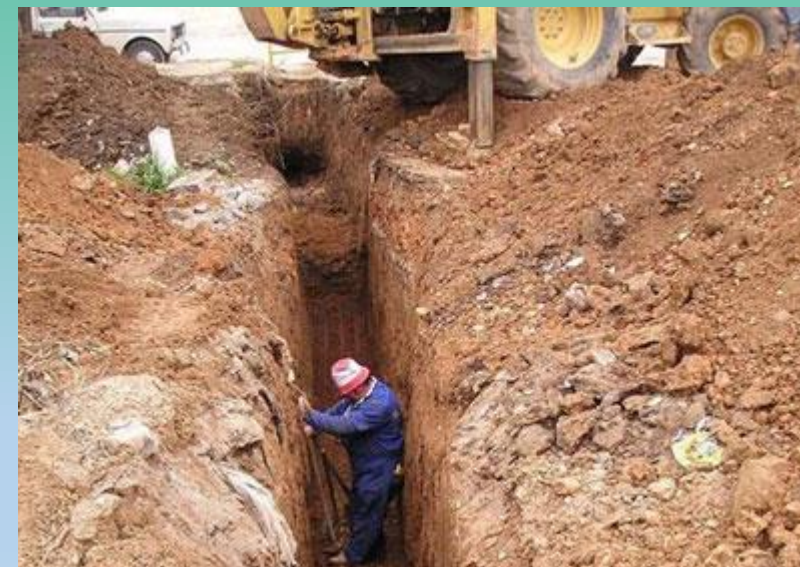
Excavación manual
