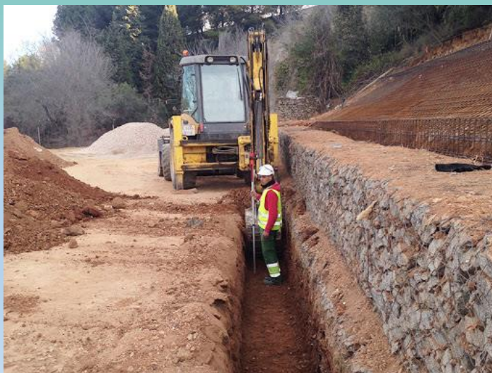
Se encuentra una maquina haciendo una excavación
