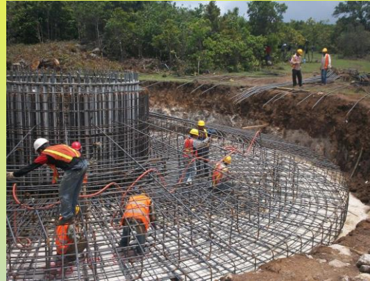
Se encuentran personas haciendo la armadura de cimentación
