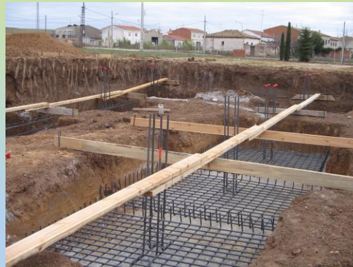
Zapata aislada, se encuentra una pasarela
