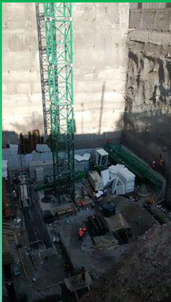
Podemos observar que se trata de una excavación profunda
