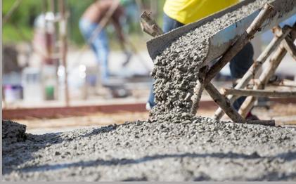
El concreto hidráulico es una mezcla de agregados pétreos naturales, procesados o artificiales, cementante y agua, a la que además se le puede agregar algunos aditivos.
