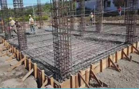
UNA LOSA DE CIMENTACIÓN ES UNA PLACA FLOTANTE APOYO DIRECTAMENTE SOBRE EL TERRENO, ESTA ESTÁ SOMETIDA PRINCIPALMENTE A ESFUERZOS DE FLEXIÓN.
