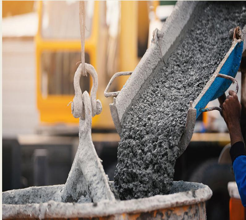
El concreto hidráulico es una mezcla de agregados pétreos naturales, procesados o artificiales, cementante y agua, a la que además se le puede agregar algunos aditivos.
