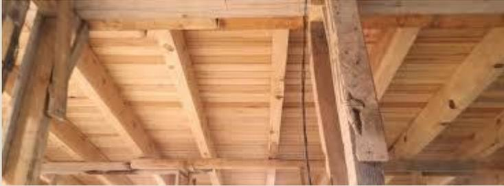
“ES LA ESTRUCTURA PROVISIONAL O MOLDE QUE SOPORTA AL CONCRETO MIENTRAS ESTÉ FRAGUANDO Y LOGRA LA RESISTENCIA SUFICIENTE PARA SOSTENERSE A SÍ MISMA”
