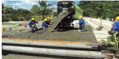
La temperatura ideal del concreto durante el colado debe fluctuar entre los 17°C y 20°C. Un colado realizado a más de 32°C requiere de mayores cuidados durante el proceso.
