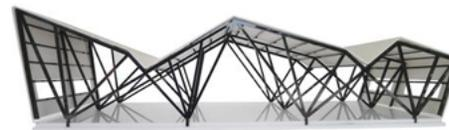
La forma en que trabajan es cambiando la dirección de las fuerzas, dividiendo las cargas en diferentes direcciones a través de dos o más barras y las equilibran mediante las correspondientes reacciones.
