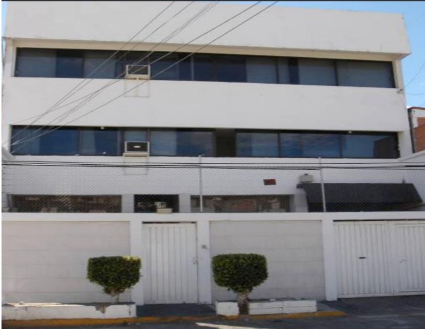
Imagen 7: Laboratorios de concretos “laboratorio de control de calidad para la industria de la construcción”
