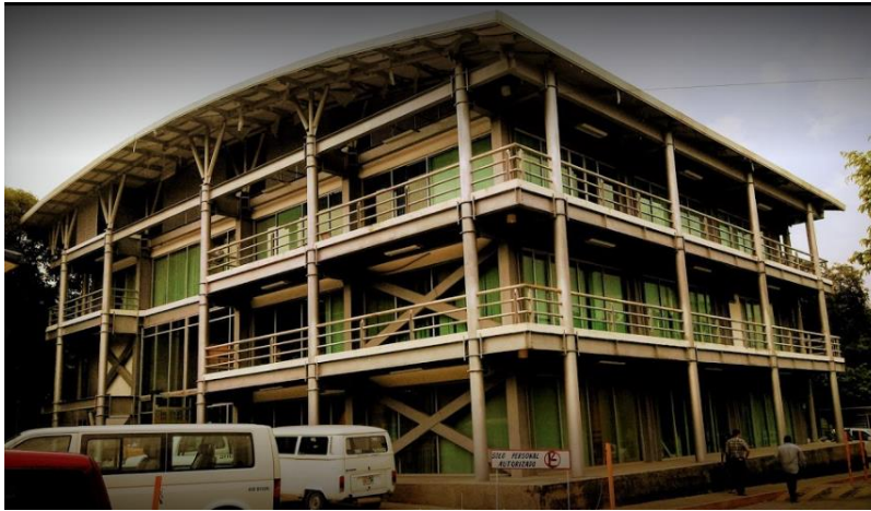
Imagen 8: Laboratorio de Mecánica de Suelos, Resistencia de Materiales y Tecnología del Concreto
