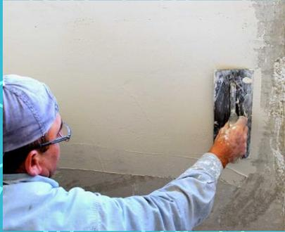
**APLANADOS:** Mezcla que sirve para el recubrimiento de elementos horizontales y verticales utilizan materiales como el cemento agua, cal y arena.
