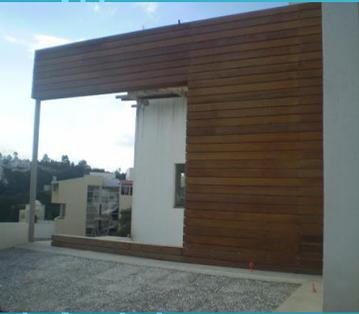
**LAMBRINES:** Es un recubrimiento para paredes ya sea en el exterior o interior de los inmuebles.
