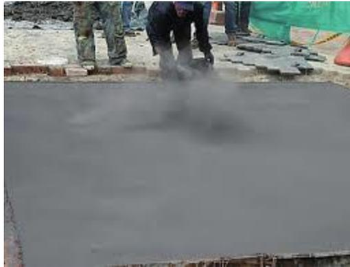
Es un compuesto diseñado para ser utilizado como un retardante de la evaporación en obras de concreto extendido de todo tipo.
