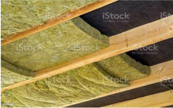
**Lana mineral:** Material flexible de fibras inorgánicas constituido por un entrelazado de filamentos de materiales pétreos que forman un fieltro que contiene y mantiene el aire en estado inmóvil, peso  $30 \text{ kg/ m}^3$ .
