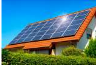
Energía Solar Fotovoltaica
