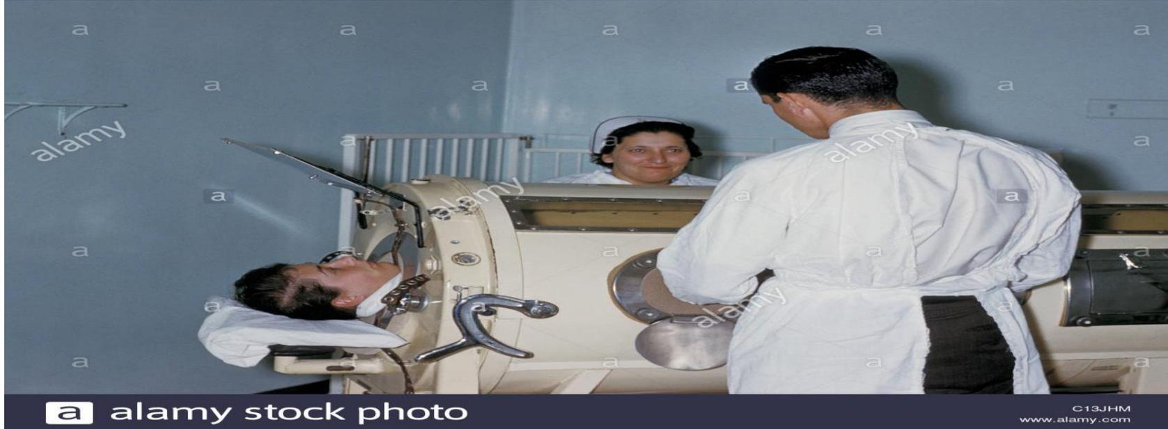
**muestra el respirador de tanque con el cuerpo de un paciente en el interior del tanque y la cabeza que sobresale a través de un collar flexible, pero estanco. En el extremo del tanque contrario a la cabeza del paciente, un diafragma de cuero activado por un motor se mueve hacia atrás y hacia delante con un movimiento suficiente para elevar y reducir la presión en el interior del tanque.**
