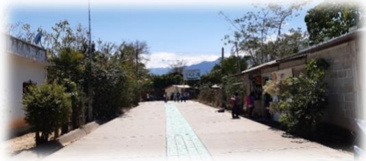
VISTA DE LAS CALLES PAVIMENTADAS
