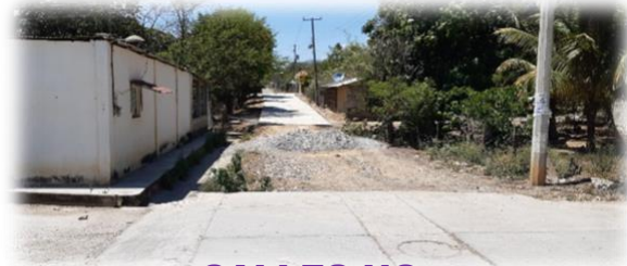
CALLES NO TERMINADAS
