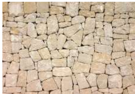
Foto 3. Muro de piedra natural.
