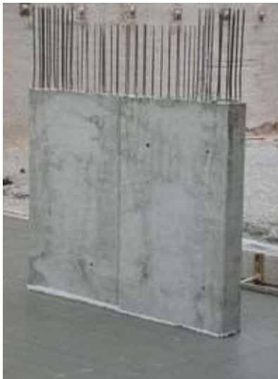
Foto 4. Muro de hormigón.
