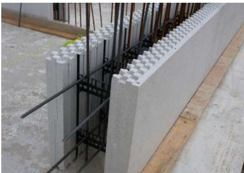
Foto 1. Muro de carga.
