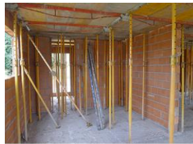
Estructura de muros de carga termoarilla
