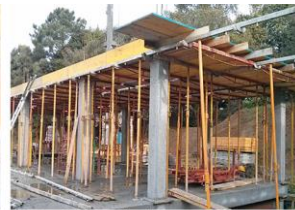
Estructura de pilares de hormigón
