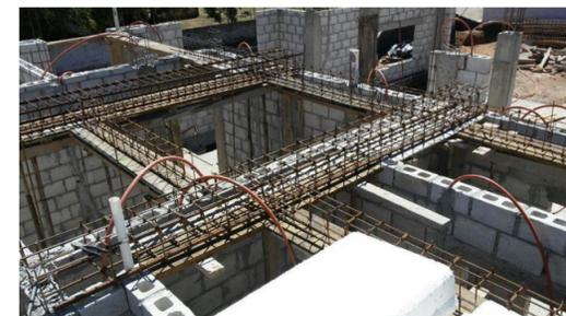
**Función:** sirve para reforzar y darle firmeza a una construcción; regularmente sirve para sostener techos, muros o la parte superior de las ventanas.
