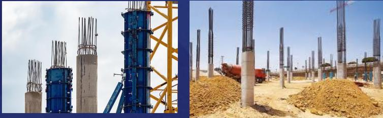
Se utiliza en una construcción de una casa o para soporte de puentes, ya que sirve para soportar el carga de toda la estructura
