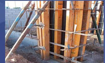
el espesor de una columna puede ser de 30 cm en ocasiones puede variar debido a la fuerza que va a soportar
