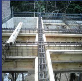
se utiliza regularmente para sostener techos, muros, también en puentes o la parte superior de las ventanas para darles firmeza y que no tengan problemas después del proceso, les permite reforzar la estructura.
